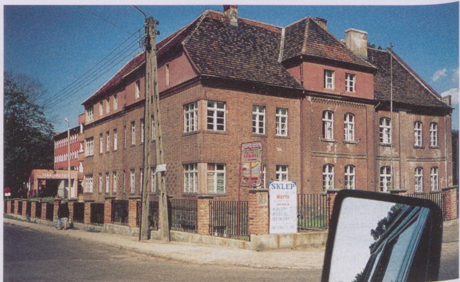
Zielenzig / Sulęcín, Krankenhaus
