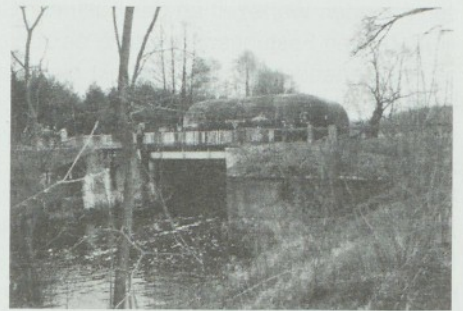
Wasserschloß-Auslaufbauwerk mit Kipprollbrücke am Nischlitzsee Foto: Günnel
