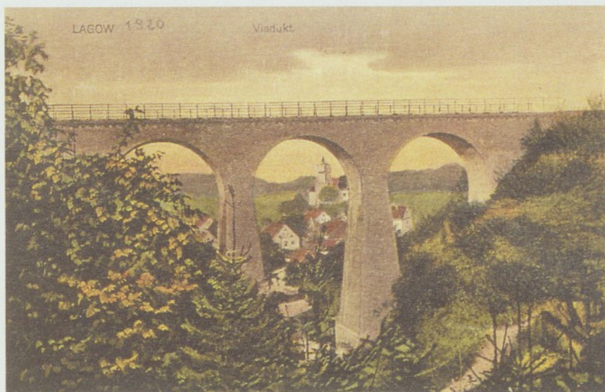
Das zweite Wahrzeichen Lagows: der große Viadukt, an der Selchower Straße für die Eisenbahnlinie Topper–Meseritz, errichtet 1909 Postkarte von 1920
