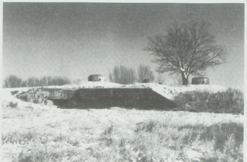
Panzerwerk 717 der Festungsfront Hochwalde-Kallau, Ansicht von der Rückseite, die Festungsanlage ist unbeschädigt Foto: Jurga
