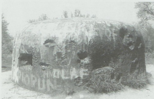
Stahlkuppel des Panzerwerks 717, Pz-Stärke 250 mm, aus bestem Stahl, panzergranatensicher Foto: Golski-Fast
